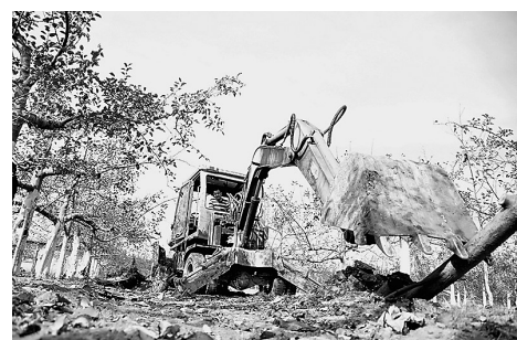
洛川县朱牛便民服务中心沟曲头村老园挖改现场
