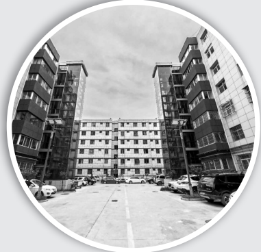
● 改造后的老旧小区
