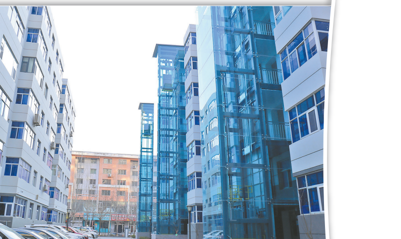
● 老旧小区改造项目完工
