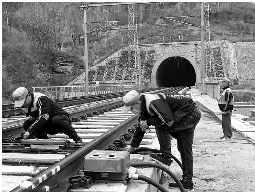
● 工作人员在检修铁轨
