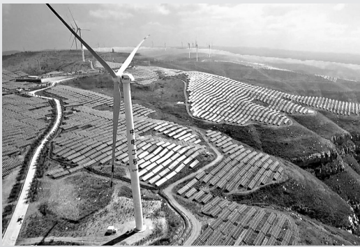
● 风电项目运行中
