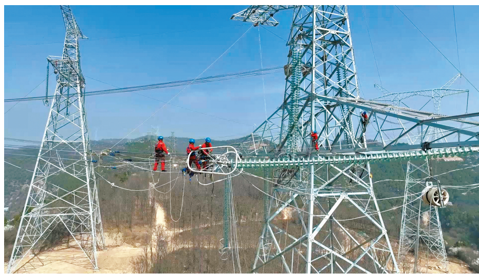
● 电力工人正在进行线网架设
