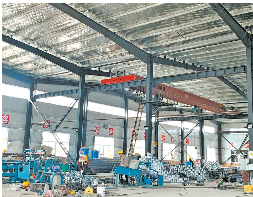
● 排架式轻钢屋架结构的厂房内工人们正忙着作业
