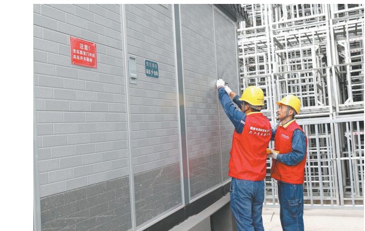
● 电力服务队员检修涉果企业用电情况
