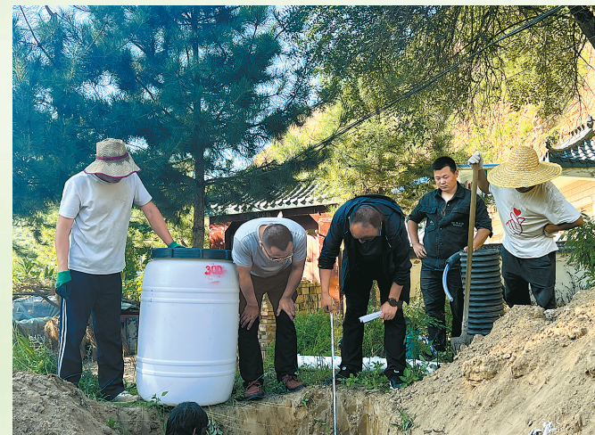
● 张彦华(右三)和施工人员进行测量预埋粪池深度
