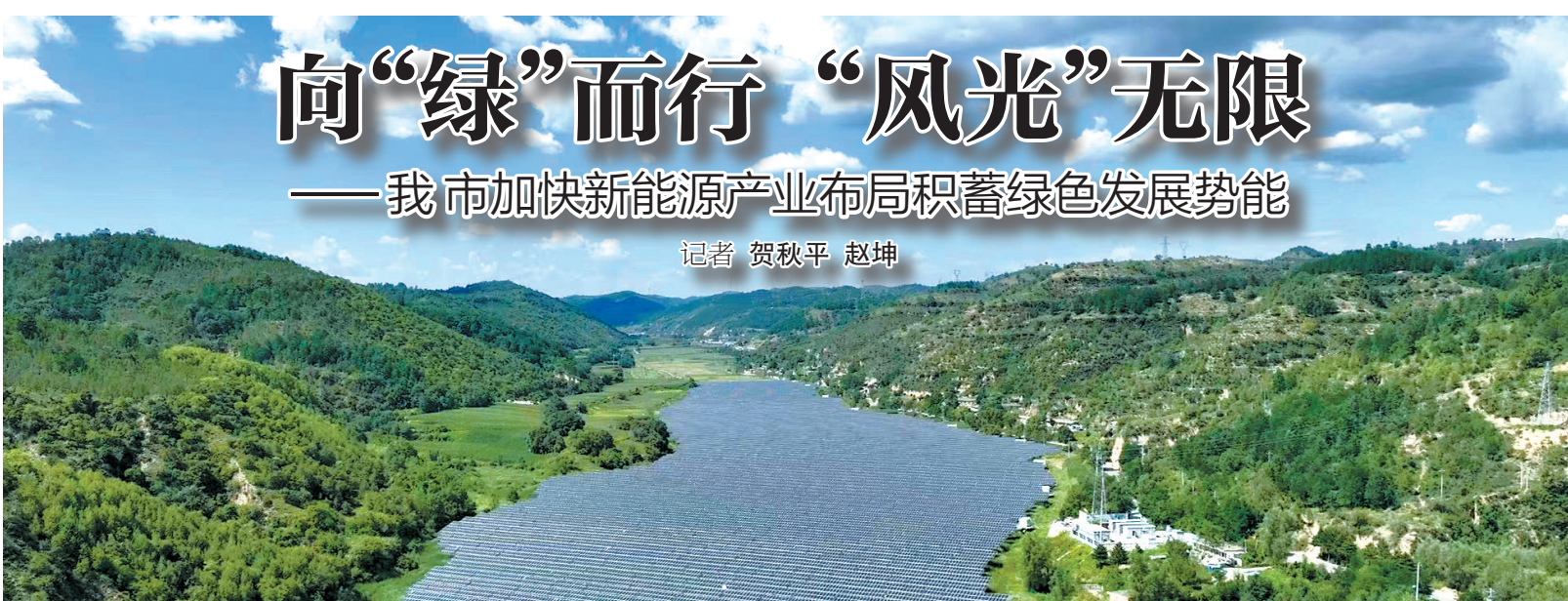
延安市宝塔区新能源开发有限公司松林光伏电站
