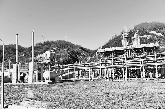
● 宜川县BOG提氮项目已正式投产运行
