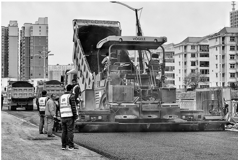
吴起县青云路正在进行路面铺设
