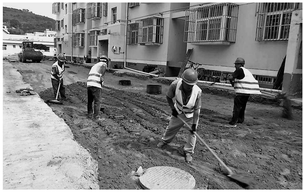
● 老旧小区正在改造施工
