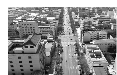
洛川县城中心街道路全新“出镜”
