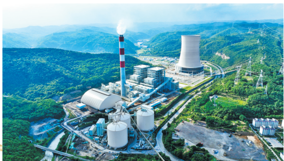
● 黄陵发电公司2×660MW电厂项目实现“双机双投”
