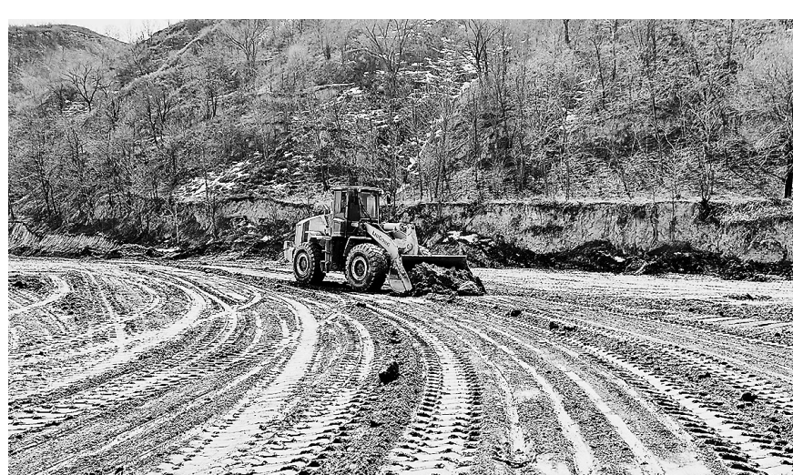
施工现场,机械正在作业
