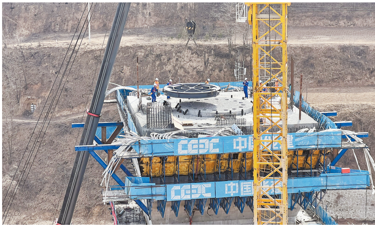
南泥湾机场大桥转体球铰安装施工现场
