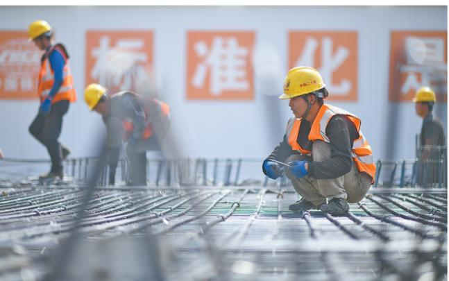
4月17日,工人在中铁二十局集团洛川制梁场进行钢筋绑扎作业。
