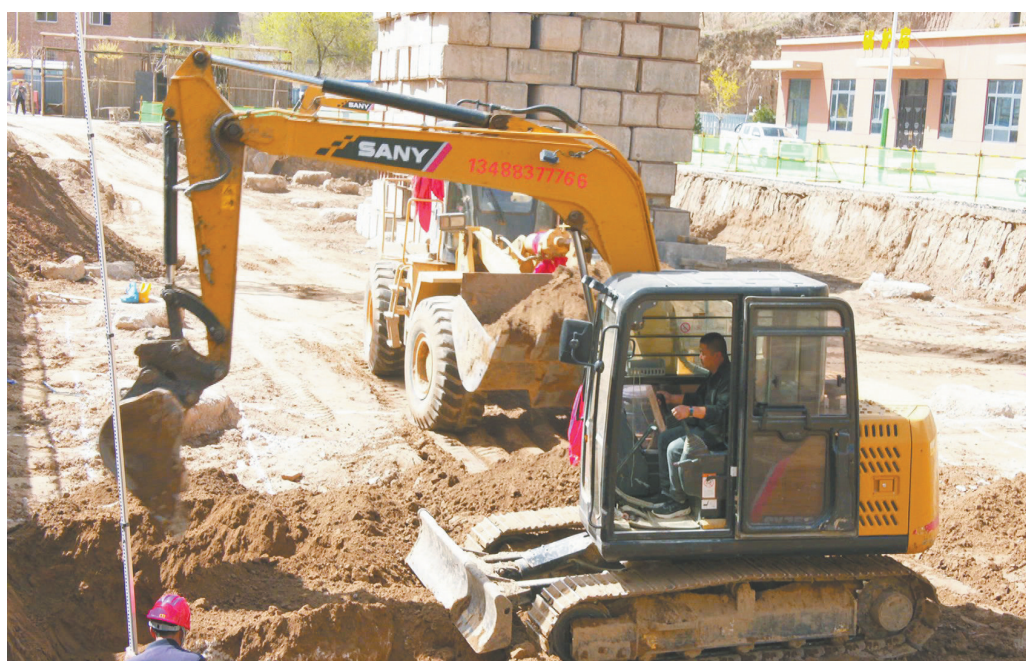
● 工人正在进行桩基施工
