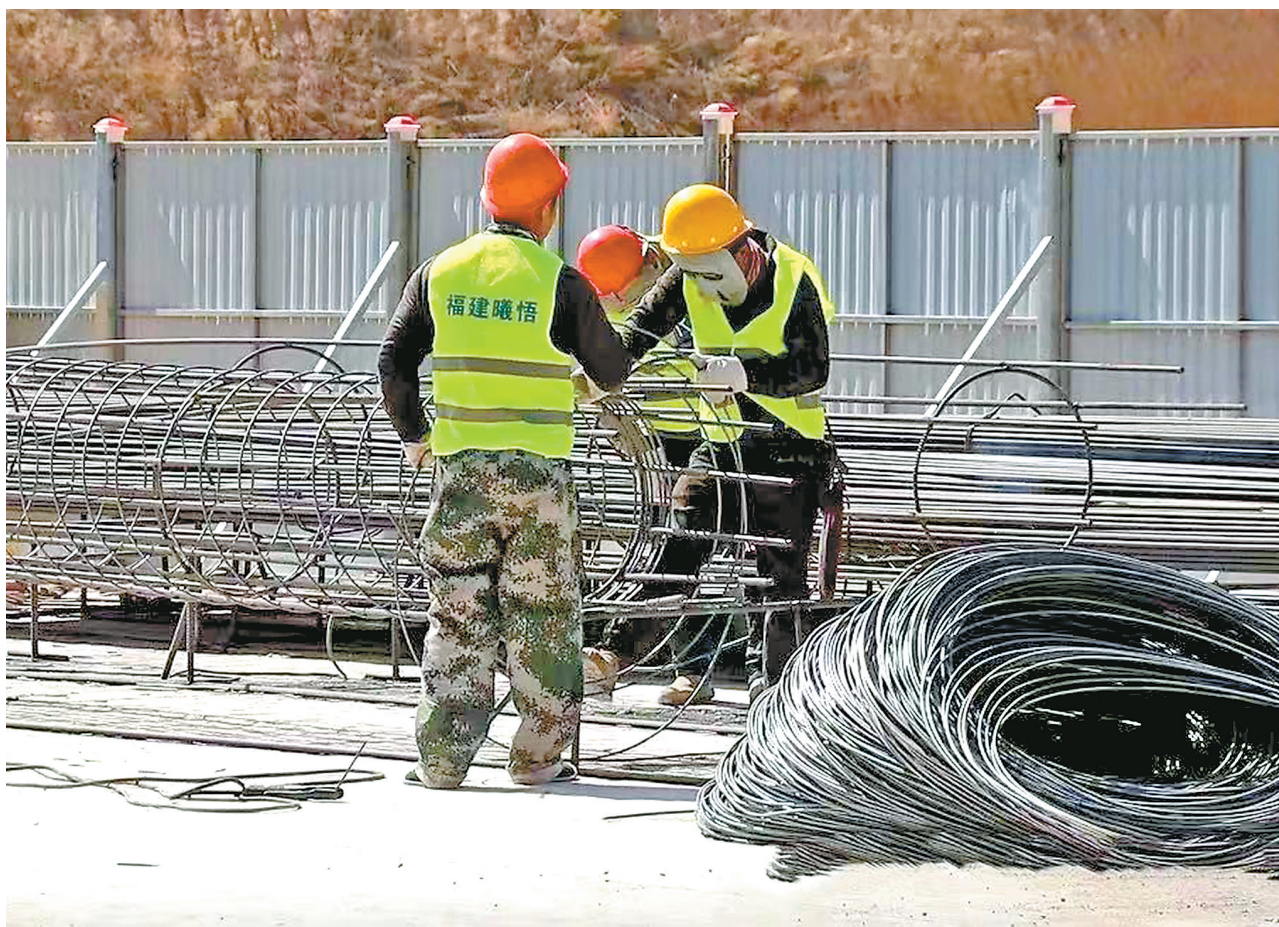
● 工人们在加速推进工程建设
