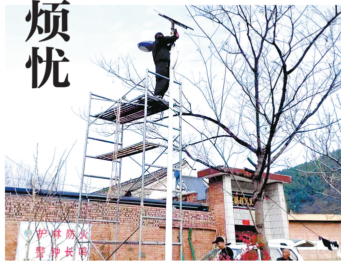
● 维修村上太阳能路灯
