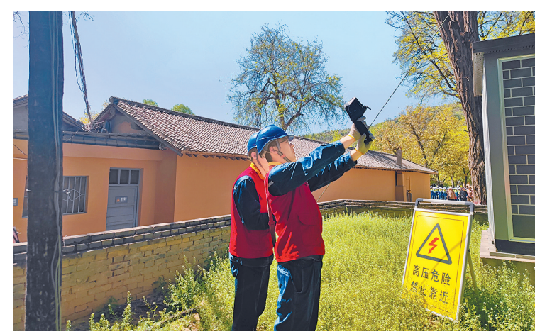
杨钰凡(右)和队友对旧址的用电设备进行隐患排查
