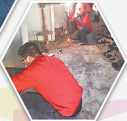
● 就业扶贫技能培训(电焊)现场
