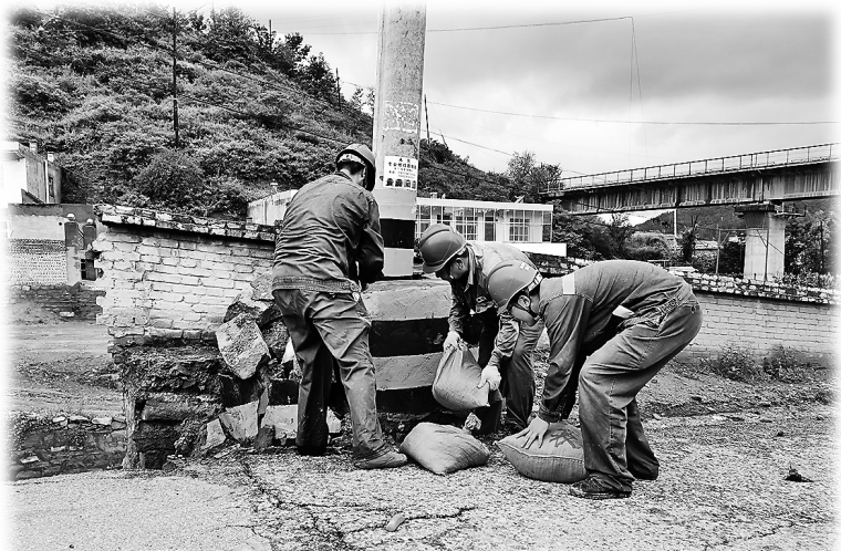
● 电力人员抢修受损电线杆
