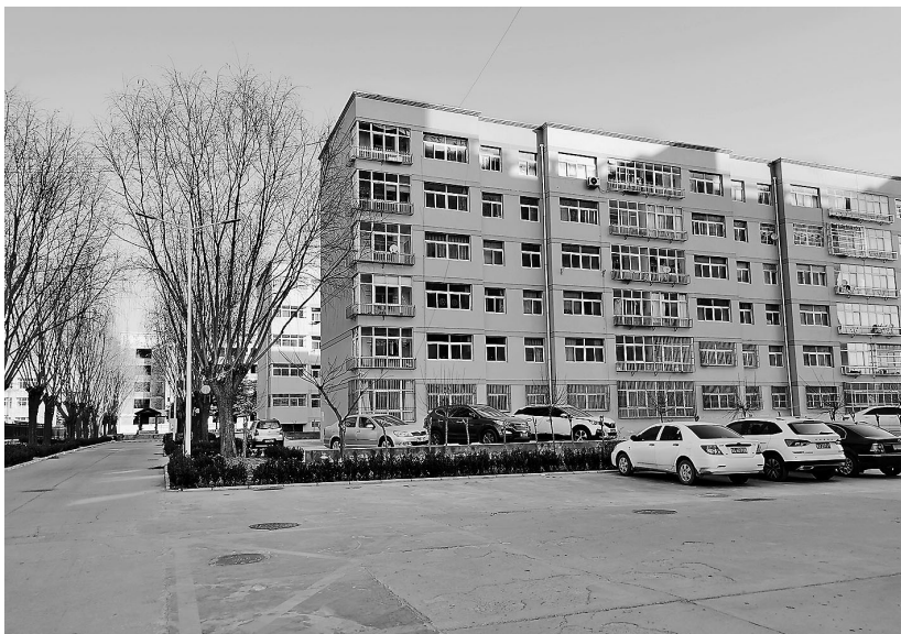
市一中家属楼老旧小区改造后图景
