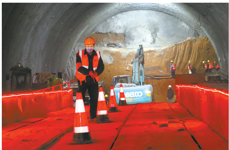
工人在隧道内施工
