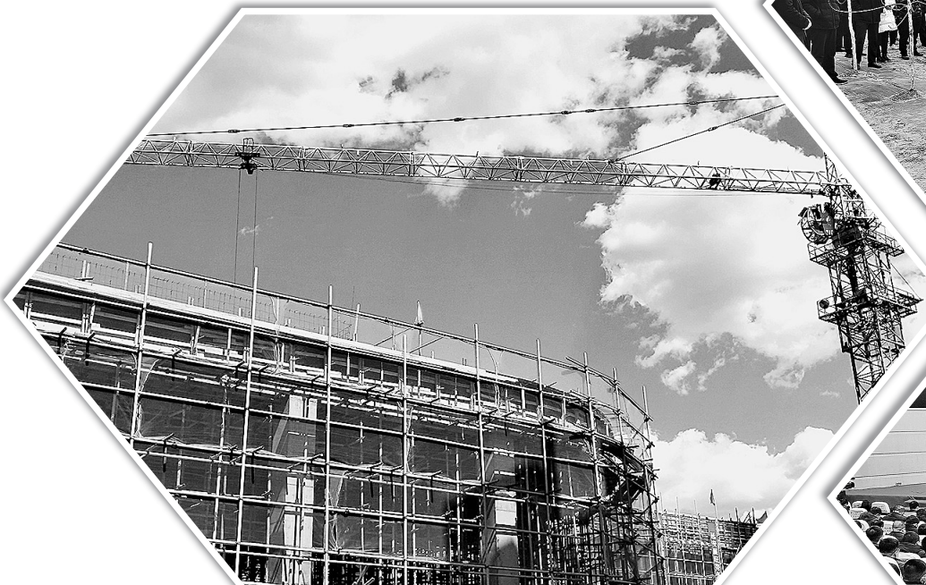
▲ 建设中的志丹县第四幼儿园
