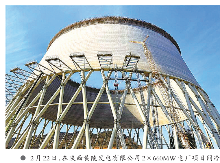
2月22日,在陕西黄陵发电有限公司2×660MW电厂项目间冷塔工地,工人们正在紧张有序施工。
