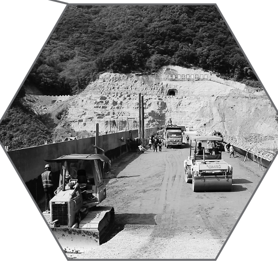
● 242国道黄龙县城过境公路工程项目施工现场
