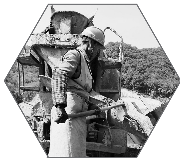
● 黄龙县公寨沟水库建设项目施工现场
