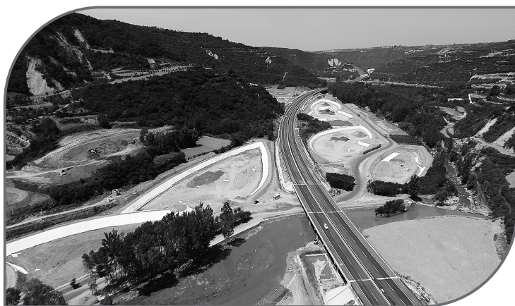
● 鸟瞰正在建设中的242国道黄龙县城过境公路
