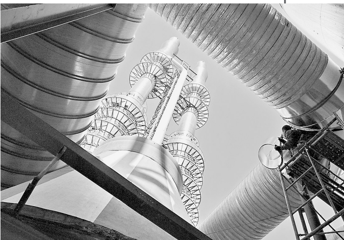
● 工人在位于河北省沙河市的河北鑫利玻璃有限公司厂区检修环保设施(2020年4月23日摄)。
