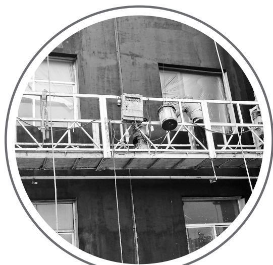
● 工人正在对老旧小区进行改造施工
