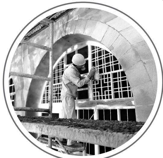
● 职教中心校舍改造维修项目
