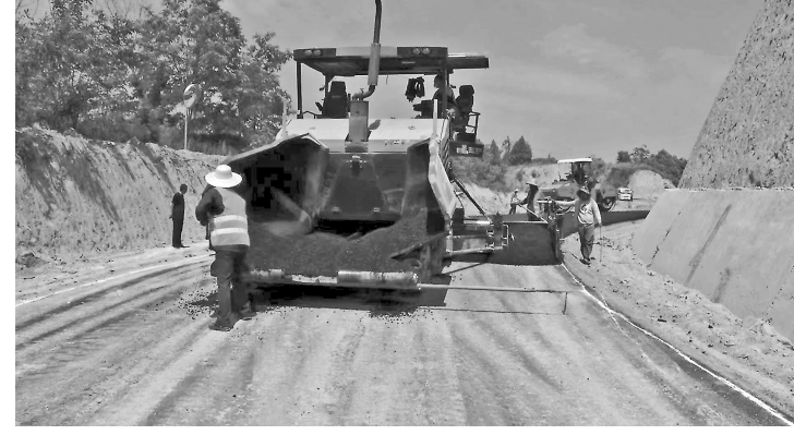
● 施工人员正在硬化道路
