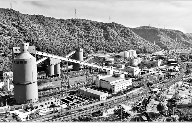
● 陕煤黄陵矿业双龙煤业公司全景
