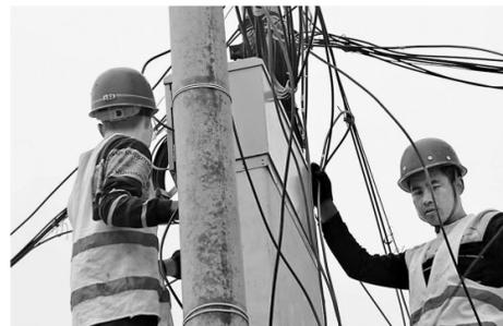
本报讯(通讯员 王刚 张敏 记者 孙艳艳)近日,在洛川县城中心街通信架空线落地项目施工现场,工人们正在清理废弃的线缆,营造安全整洁的街道环境。
