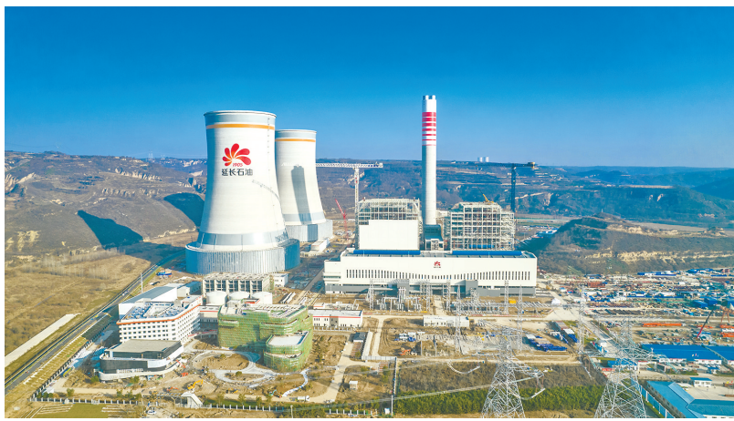
● 延长石油富县电厂项目
