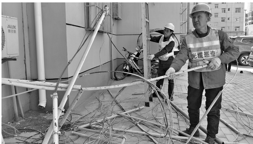
● 工人师傅清理废弃网线与pvc管
