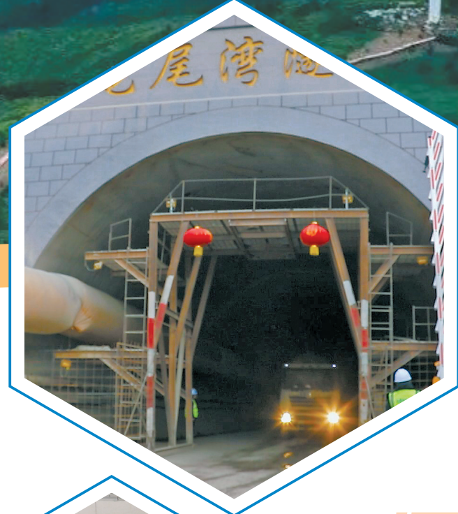
● 国道242黄龙县城过境公路龙尾湾隧道工人正在进场施工
