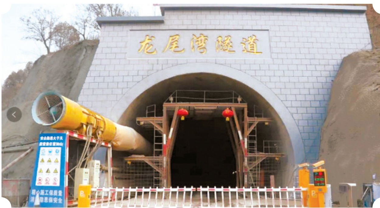
● 国道242过境线建设现场
