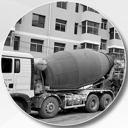
● 老旧小区改造施工现场
