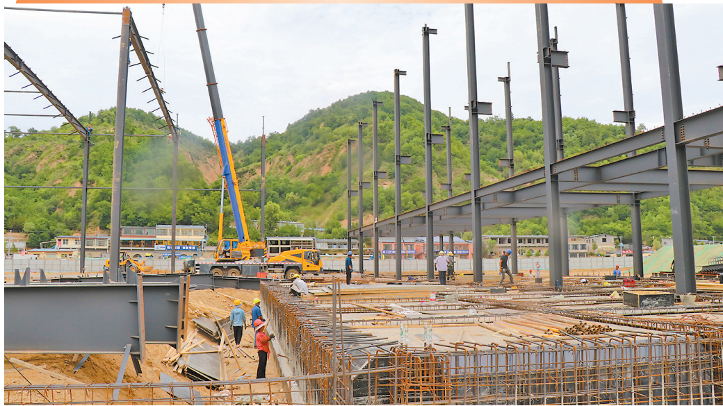
● 阳光新能源项目施工现场
