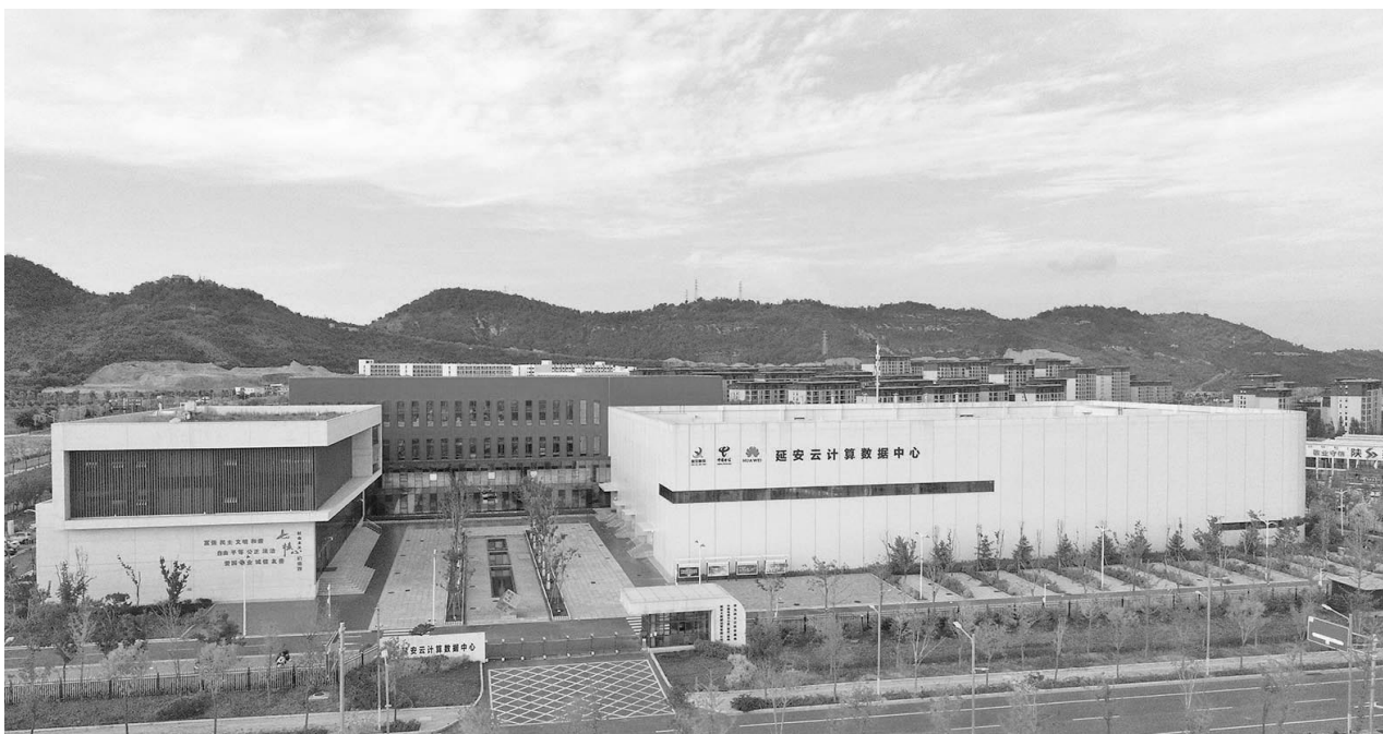
● 已运营的延安云计算数据中心一期项目
