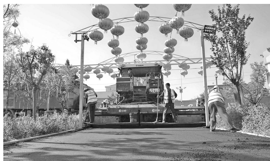
● 为破损的矿区路面铺设高精度沥青混凝土
