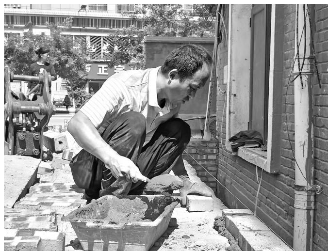
● 施工人员在作业
