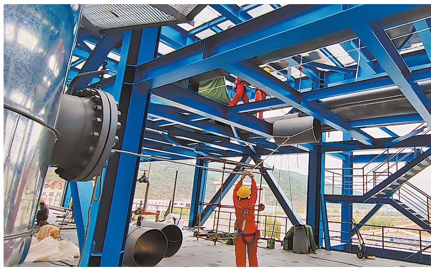
● 工业园区年产10万吨高端有机胺项目建设现场
