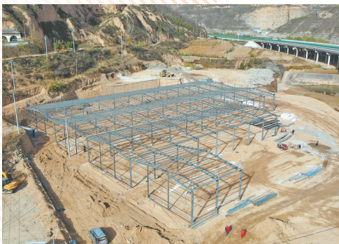
● 项目施工现场
