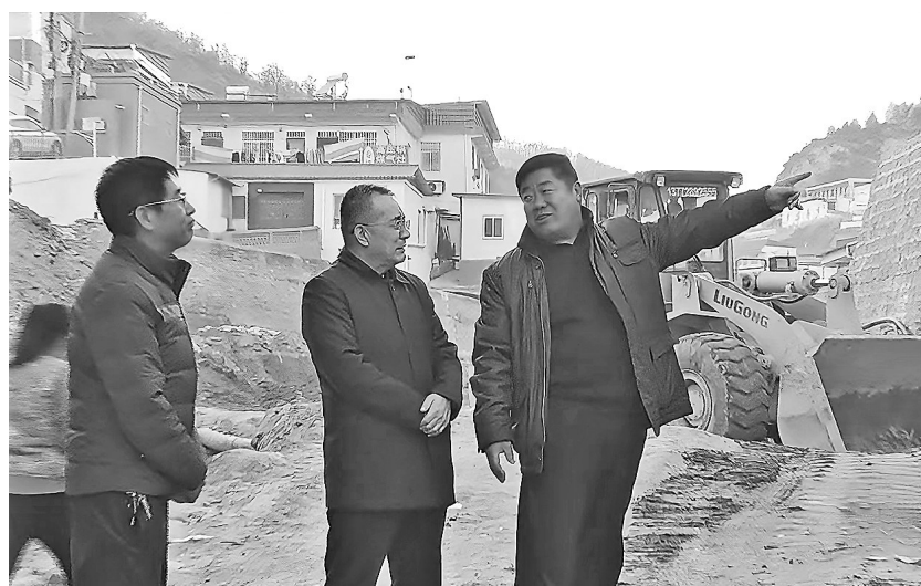
苗峰(中)深入项目施工现场检查指导工作
