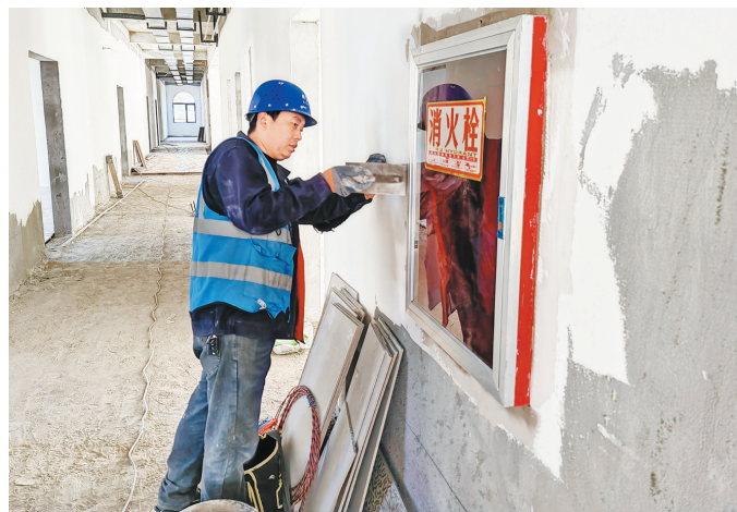
● 工人对楼内装修进行最后的“扫尾”工作
