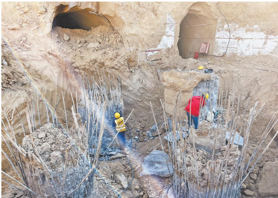
● 工人们正在进行桩基钻孔作业
