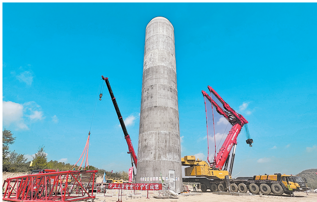
● 项目施工现场
