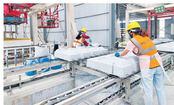
工人正在进行轨枕承轨槽裂纹检测、预埋套管防尘盖作业
