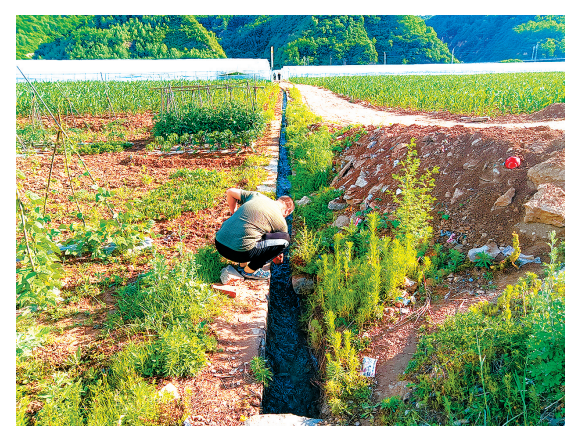
疏通灌溉渠道
