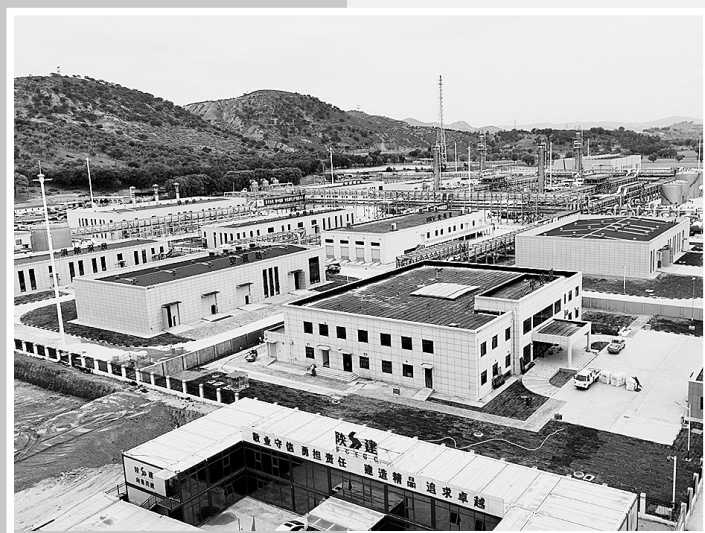
● 延安气田中区北部产能建设项目周湾净化厂
