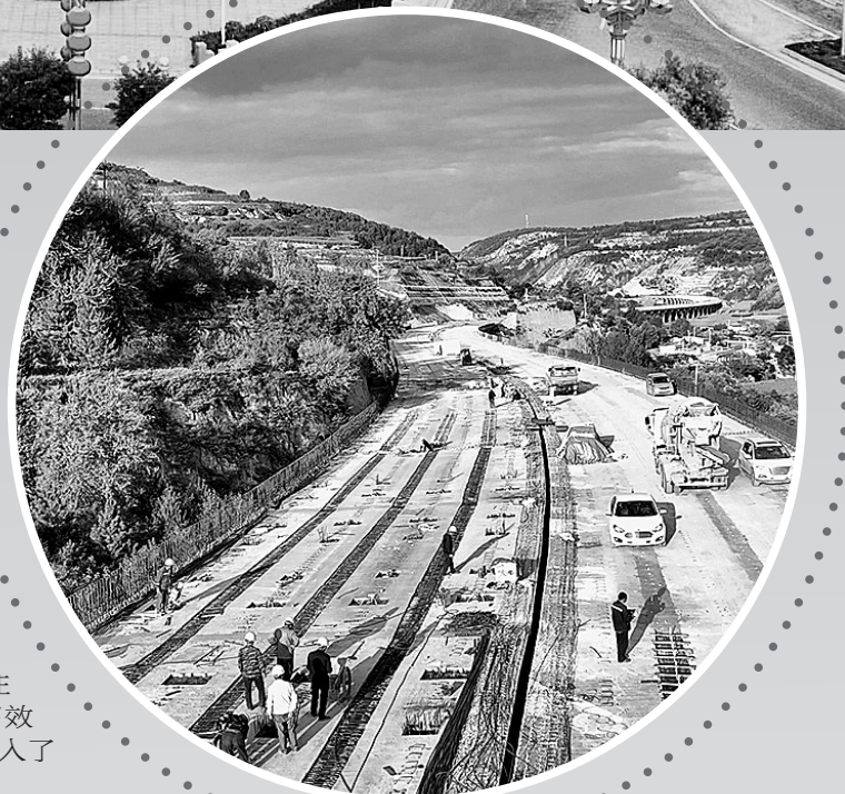
● 吴华高速项目建设现场
